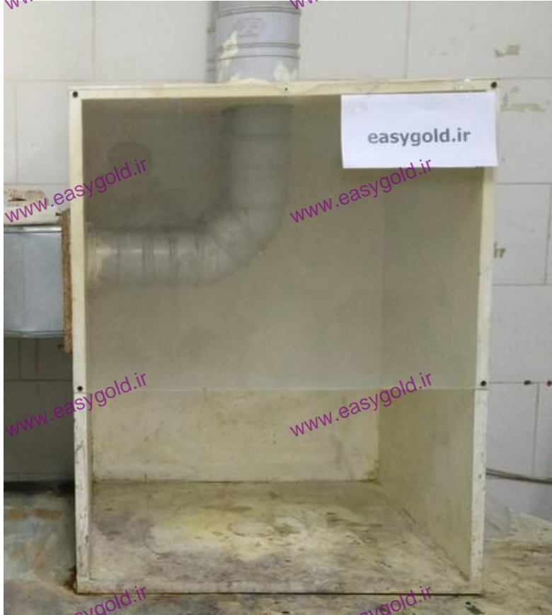
شکل ۲-۵: یک نمونه هود اسیدکاری که بخشی از فضای جلوی آن با ورق پلکسی گلاس پوشانده شده است.
